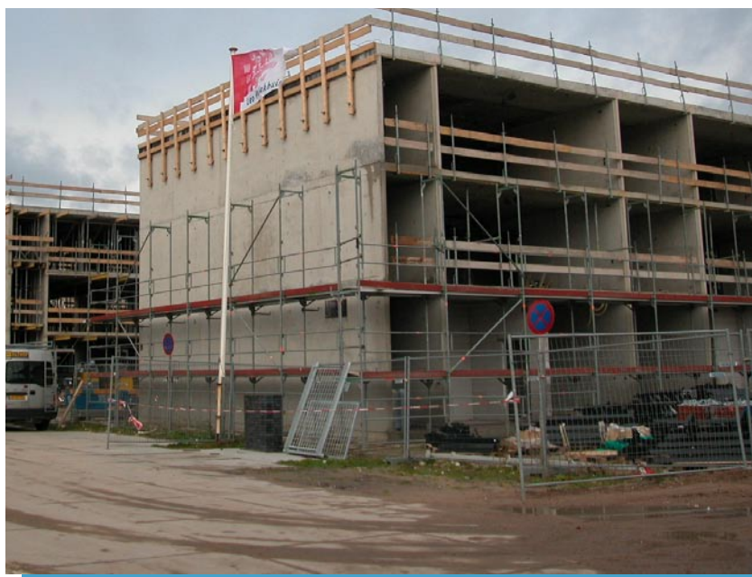
Figuur 8 Het nieuwe Leo Polakhuis in aanbouw.
